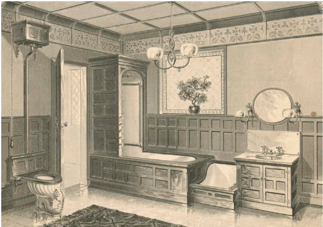
Interior del cuarto de baño por J.L. Mott Iron Works. (1888)
